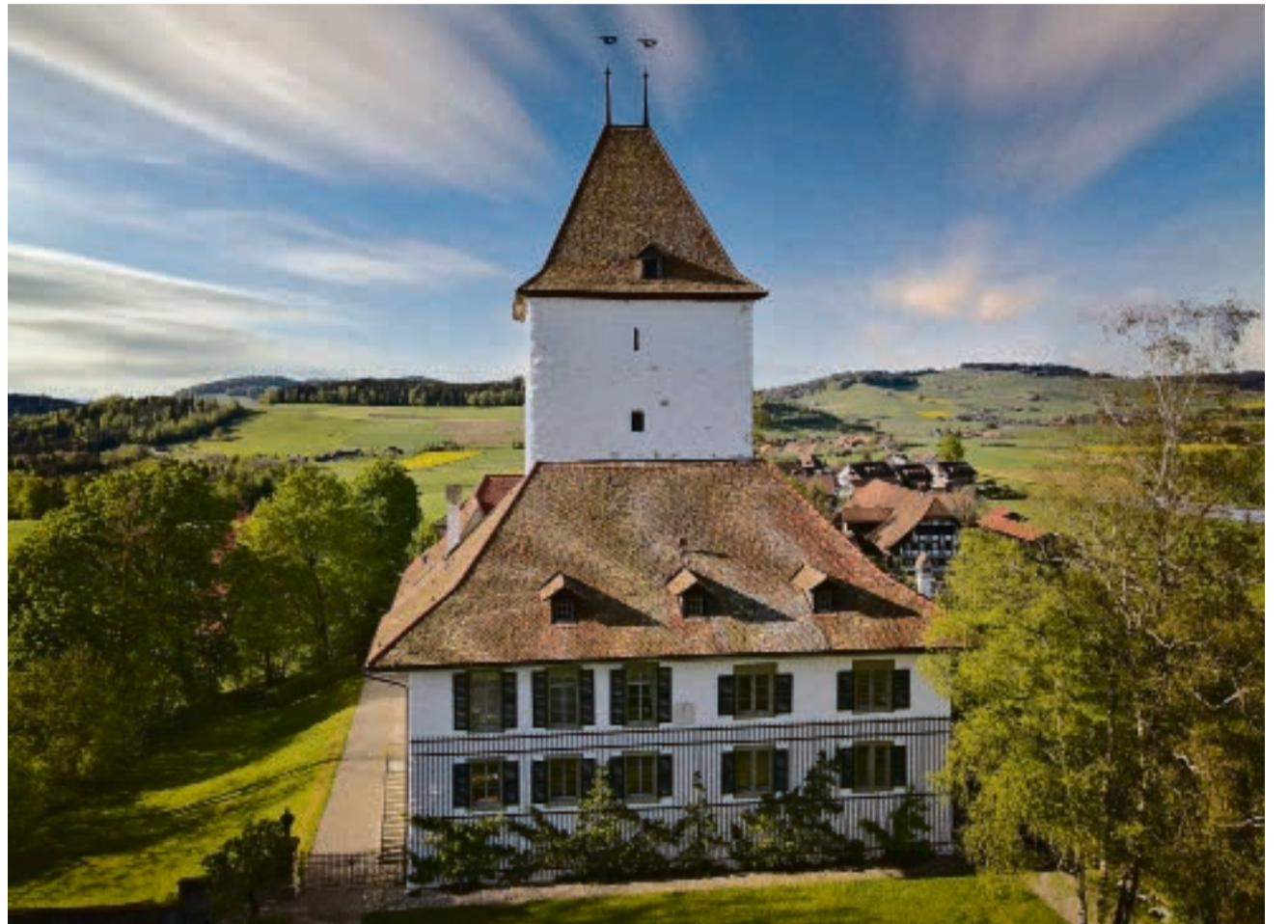
Seit zehn Jahren besitzt und betreut Matthias Steinmann das Schloss Wyl. Mit seiner Firma steckte er über acht Millionen in das historische Gebäude. zvg
